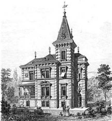
Das Geburtshaus Barényis: die Keller'sche Villa am Bach, Hirtenberg NÖ
